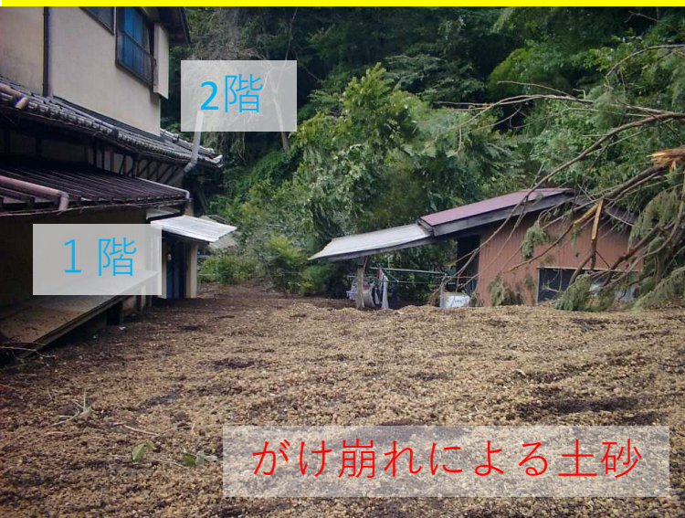
「がけ崩れによる土砂で1階部分が埋まった家」
