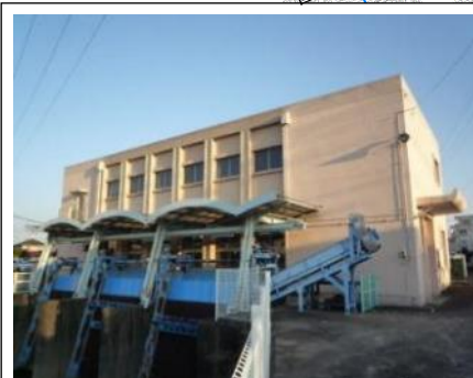
袋井排水機場
