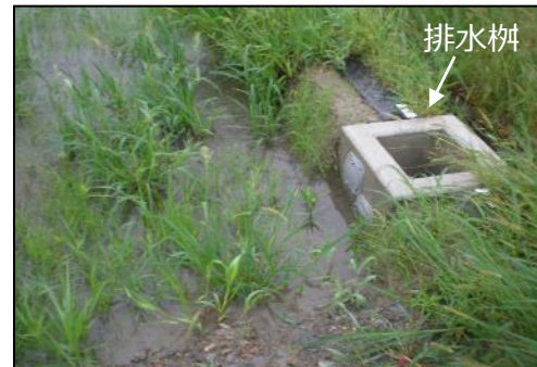
排水柵の設置
