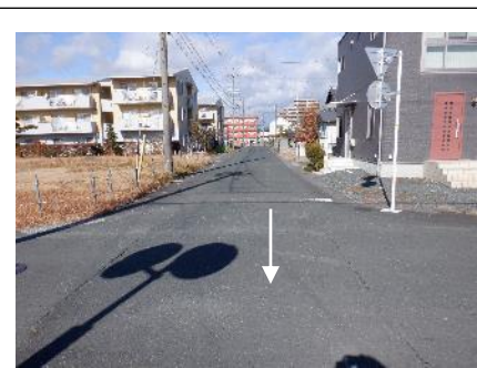
田町幹線1-2(暗渠)
