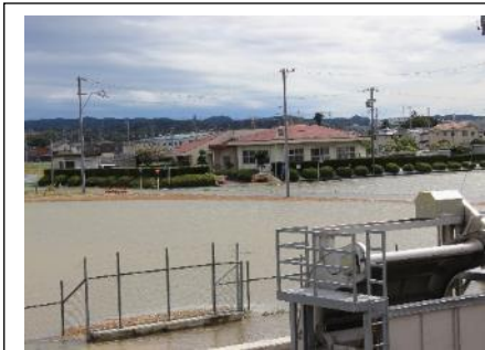
平成26年10月5～6日台風18号による田原幼稚園周辺の浸水状況
