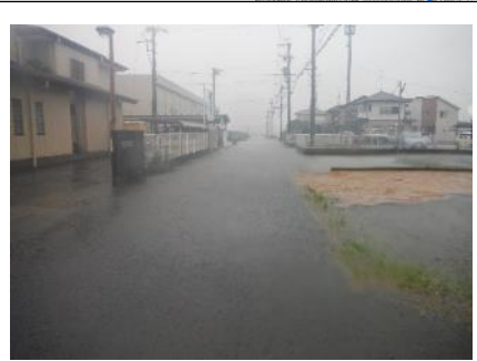
令和元年10月12日(台風19号)による道路冠水状況
