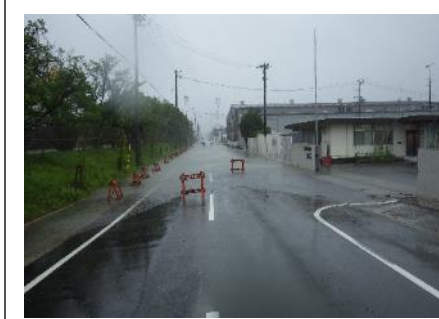
平成29年6月21日降雨による小野田田原線道路冠水状況
