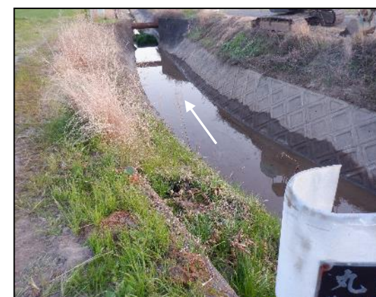
〔対策実施後〕浚渫工事の実施
