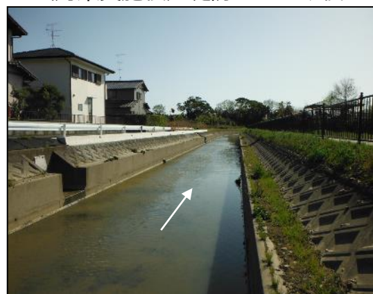
〔対策実施後〕堤防かさ上げ後
