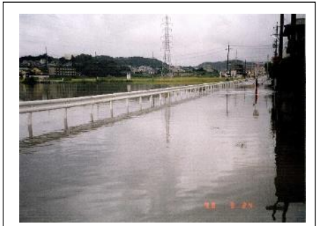
平成10年9月23～24日前線の小川町郵便局周辺の浸水状況
