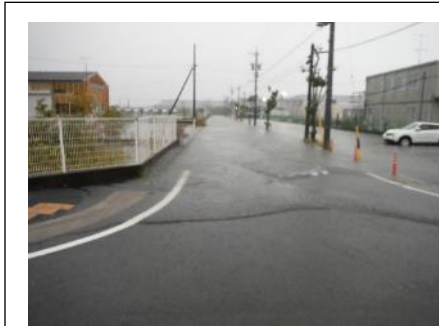
令和元年10月12日(台風19号)の新池地区道路冠水状況
