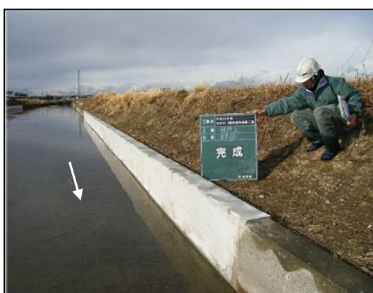
〔対策実施後〕補修工事の実施
