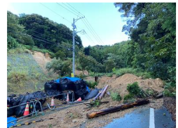
土砂崩れ(大谷地内)
