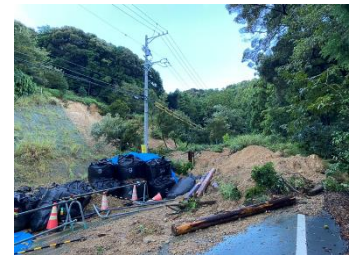
土砂崩れ(大谷地内)
