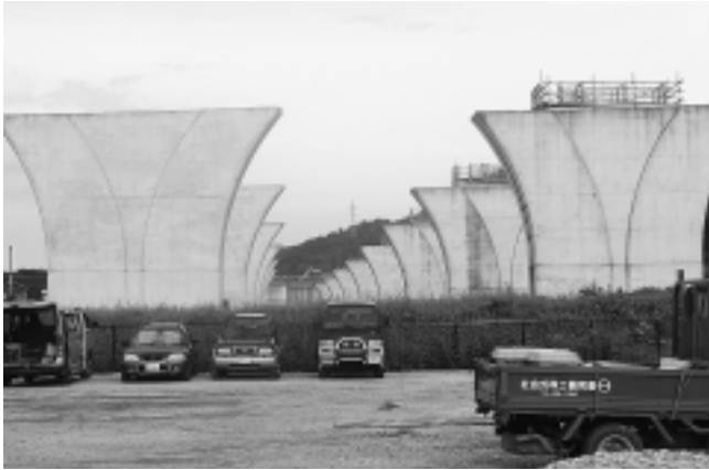
建設が進む第二東名（仮称）森掛川I.C.予定地付近
