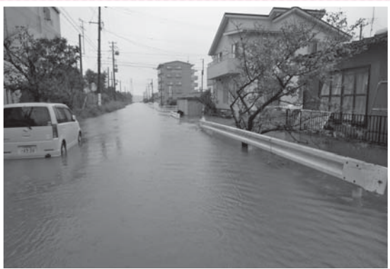
川井地区の浸水
