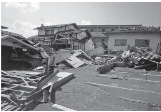
熊本地震による木造家屋の被災状況
