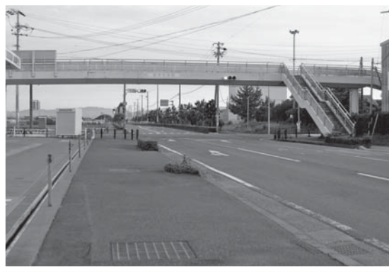
浅岡交差点の歩道橋
