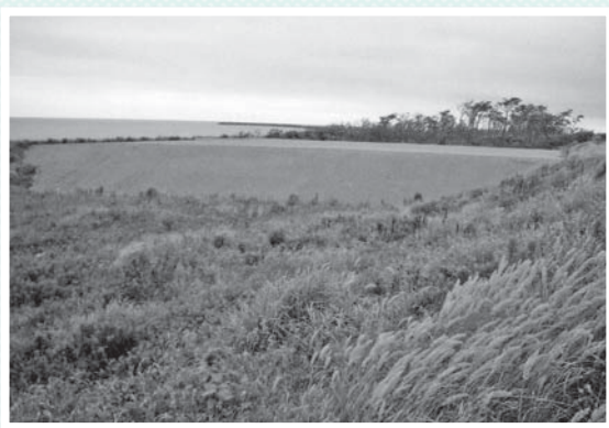
「空間デザイン」が期待される防潮堤の天端
