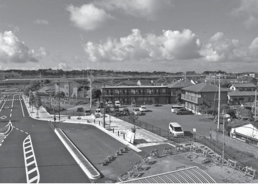
袋井駅南北自由通路駿遠口（南口）からの眺め
