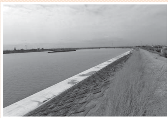
地盤改良工事を実施した太田川堤防
