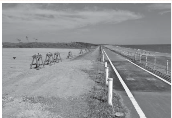
早期整備が望まれる防潮堤
