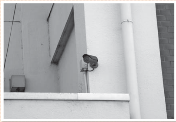
学校に設置されている防犯カメラ
