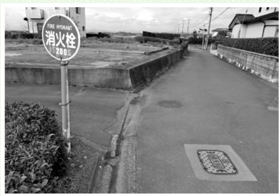
消火栓の標識
