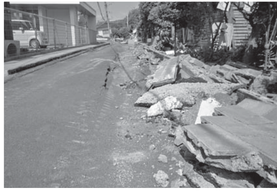
熊本地震により倒壊したブロック塀
