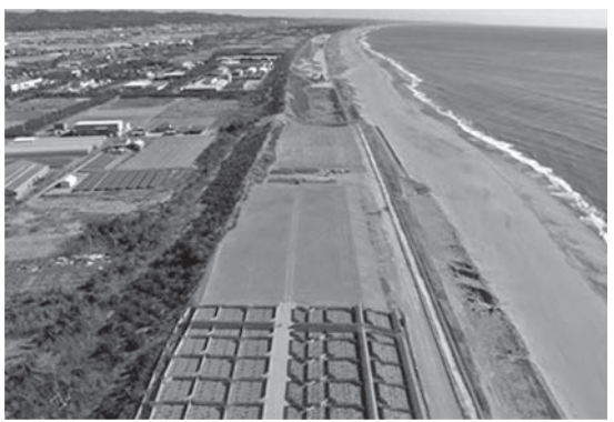
順調に進む防潮堤工事
