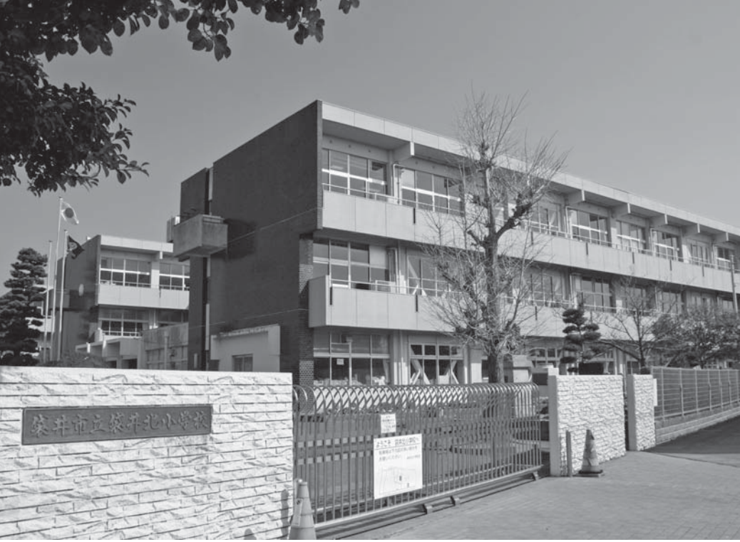
校舎増築工事が行われる袋井北小学校
