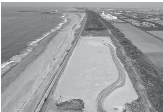
防潮堤整備事業
