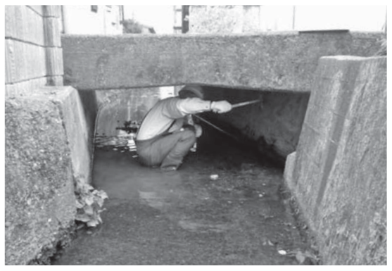
近接目視による橋梁点検
