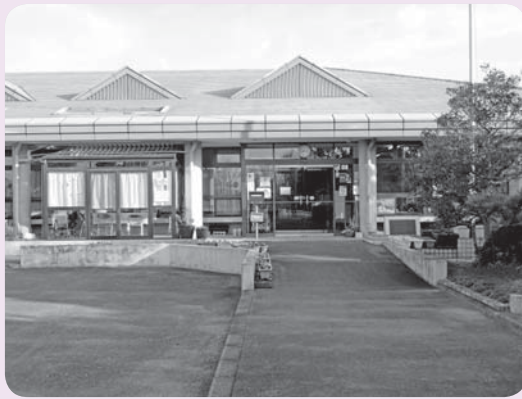
バリアフリー化が進む浅羽東コミュニティセンター
