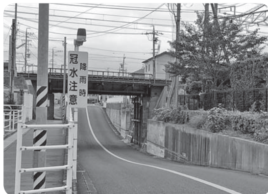
アンダーパス(下地地内)
