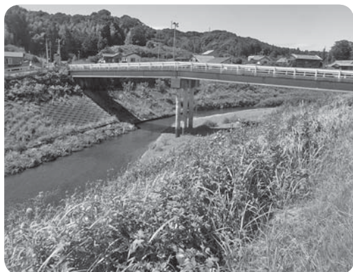
明治橋（川会地内）
