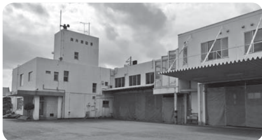
売却予定の旧袋井消防署
