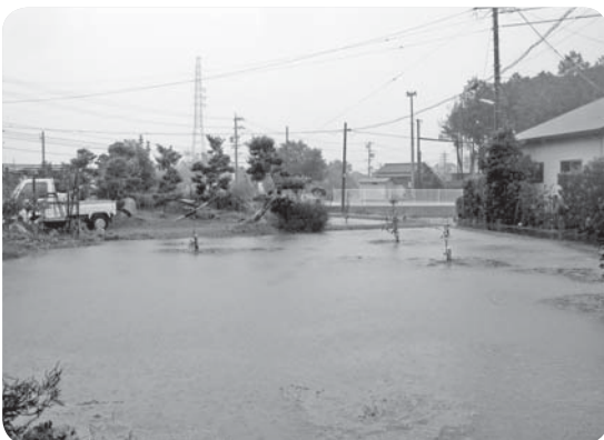
田町排水区地内の浸水被害
