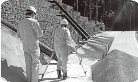
市道大谷幕ヶ谷線 災害復旧工事
