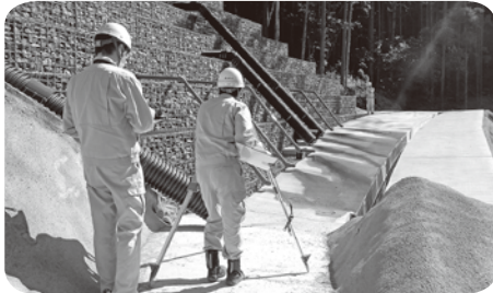
市道大谷幕ヶ谷線 災害復旧工事
