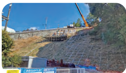
宇刈の第4配水池法面整備工事の様子
