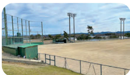
照明灯6基のうち2基が撤去されたままの「浅羽球技場」
