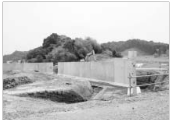
調整池の工事が進む山科東工業団地
