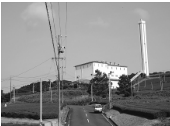
平成19年度まで稼働予定のクリーンセンター
