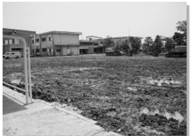
改築が行われる浅羽中学校の屋内運動場敷地
