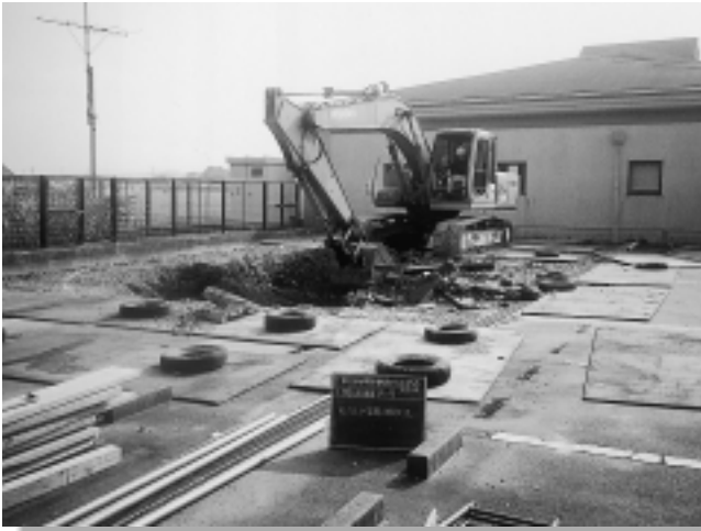
耐震性貯水槽設置工事の様子（浅羽西公民館内）
