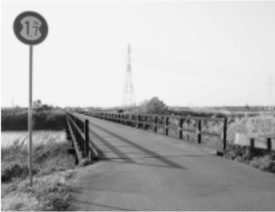
河川改修による影響が心配される「和口橋」
