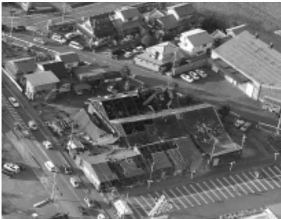
突風により大きな被害が出た諸井地区
