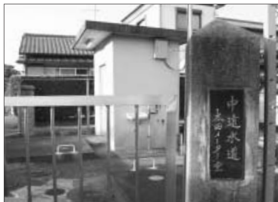
県水のメーター室(太田地内)
