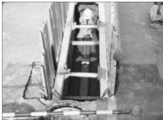
下水道管の布設工事
