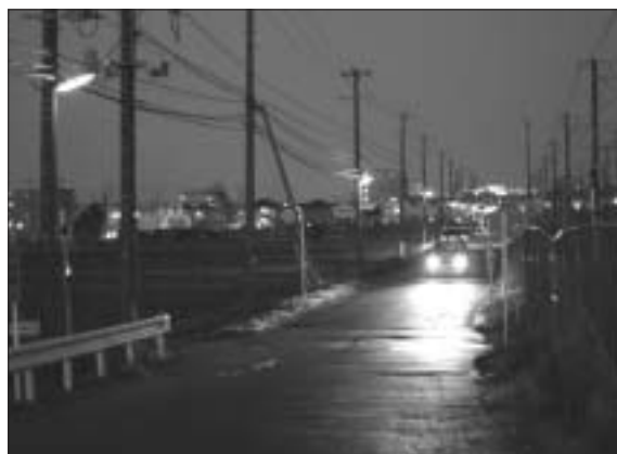
夜道を照らす防犯灯
