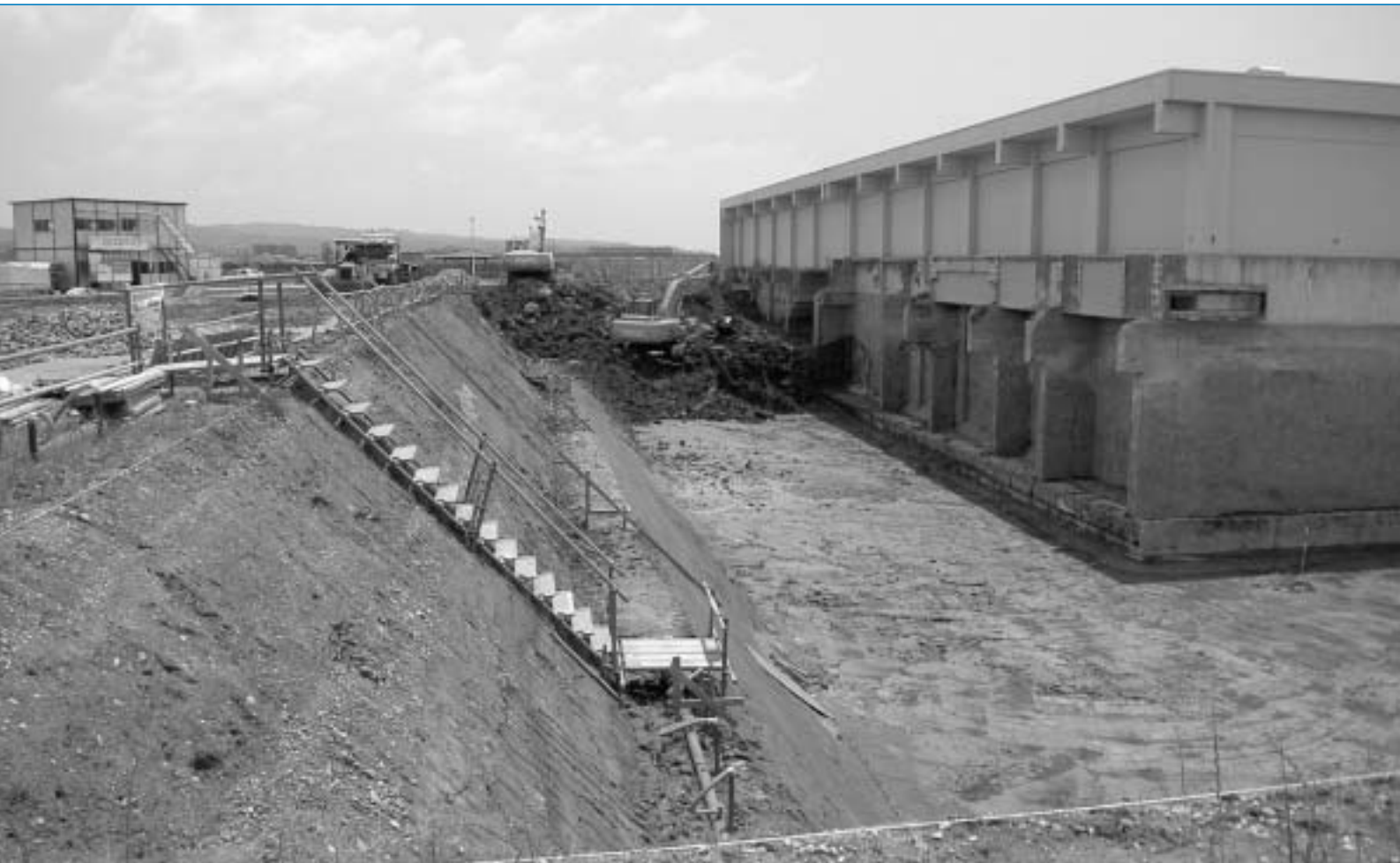
水処理施設の増設工事を行っている下水処理施設「アクアパークあさば」
