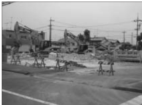
分譲が予定されている解体中のスーパーの跡地
