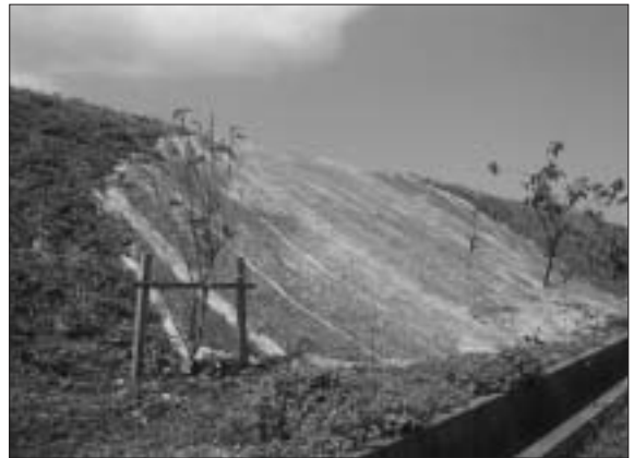
整形補修された崩落箇所
