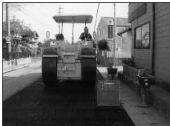
道路補修工事の様子
