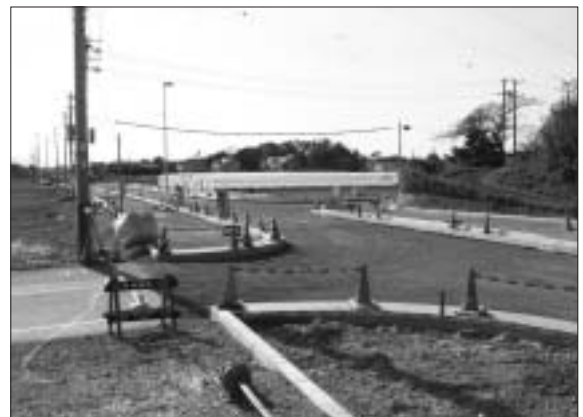
浅羽地区岡山地内の変則交差点
