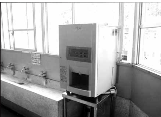
磐田南小学校に設置されている給茶機
