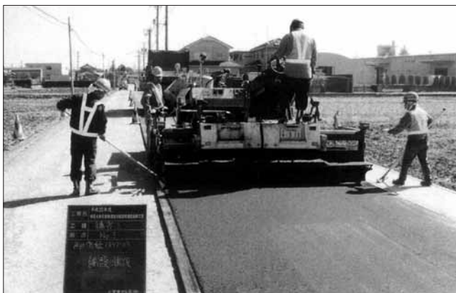
道路修繕工事の様子
