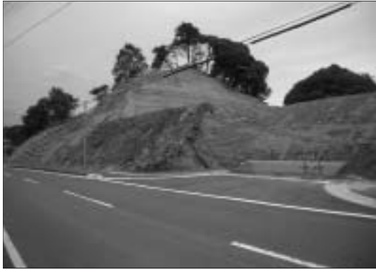
工事が進む大日ほたるの里公園
