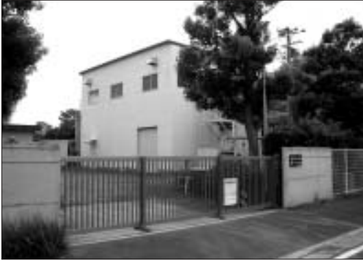
上水道第1水源地
