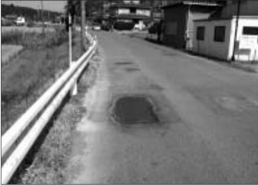
応急修繕された道路
