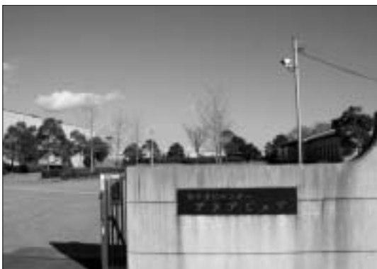
下水道処理施設袋井浄化センター“アクアピュア”
