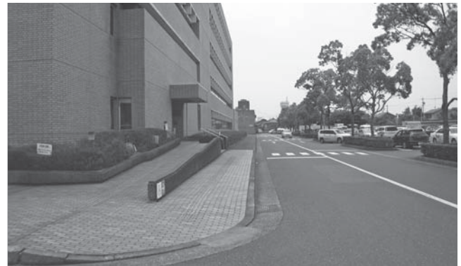
市役所本庁舎北玄関のスロープ
