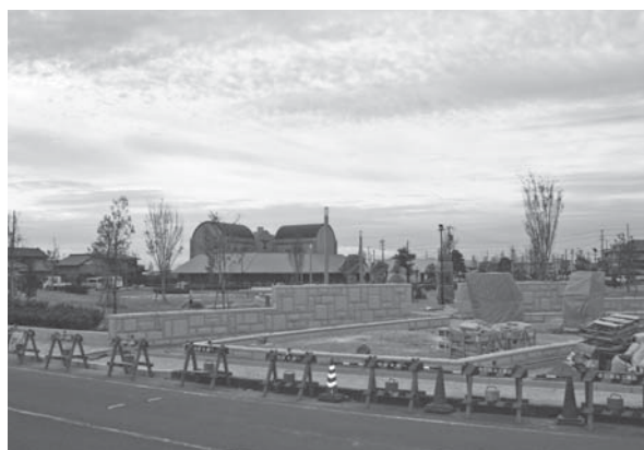
浅羽記念公園工事現場
