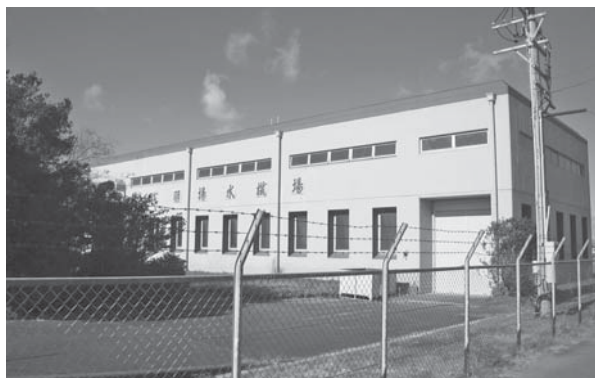
地震・津波対策が望まれる浅羽揚水機場
