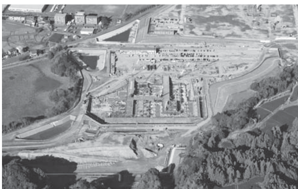
アクセスが検討されている新病院の工事現場
