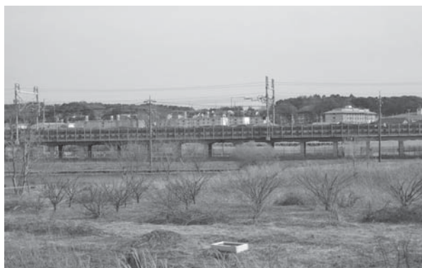
治水対策の必要性がある駅南地区
