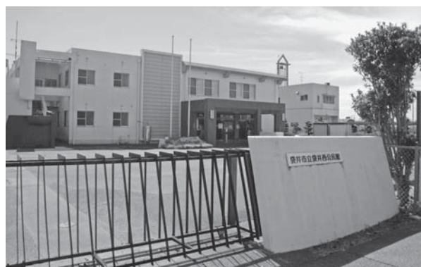
建て替えを予定している袋井西公民館
