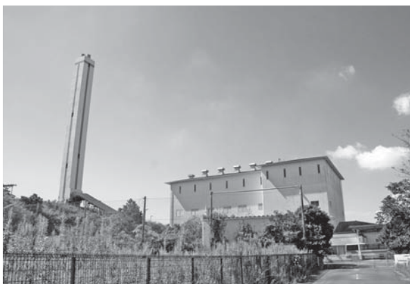
解体を進めていく旧クリーンセンター
