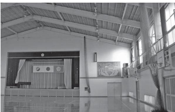
天井等の落下防止対策が進められる体育館
